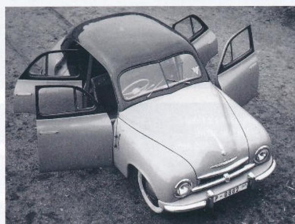
**Z nadhledu vynikají zaoblené linie pontonové karoserie se čtevící dveří**
