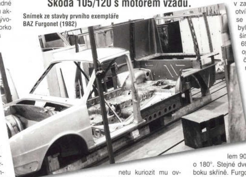
netu kuriozit mu ovšem patří čestné místo. Bratislavští konstruktéři vzali za základ sedan Škoda 105/120, z něhož použili podvozkovou plošinu s poháněcím ústrojím a přední část karoserie po střední sloupce. Rozvor náprav prodloužili o 350 na 2750 mm, aby
